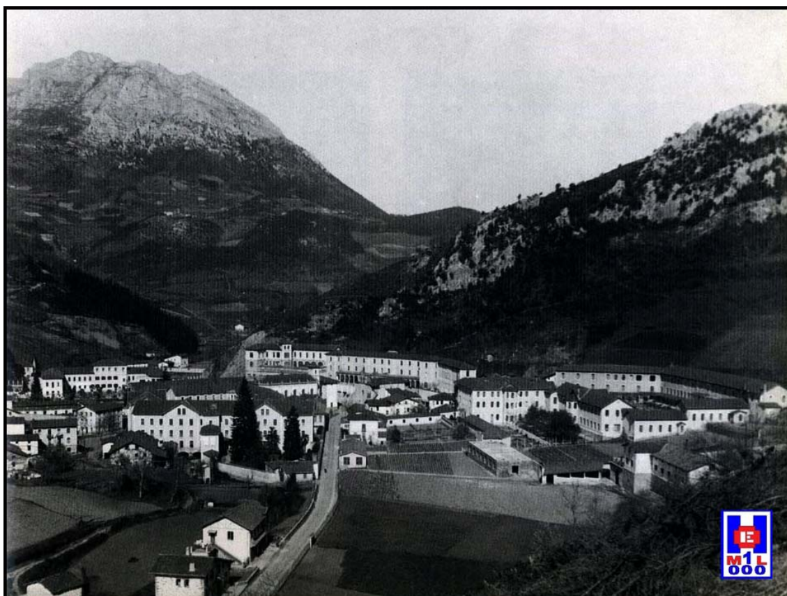
Foto 35 Vista panorámica del valle donde se encuentra enclavado el Hospital Psiquiátrico Aita Menni
